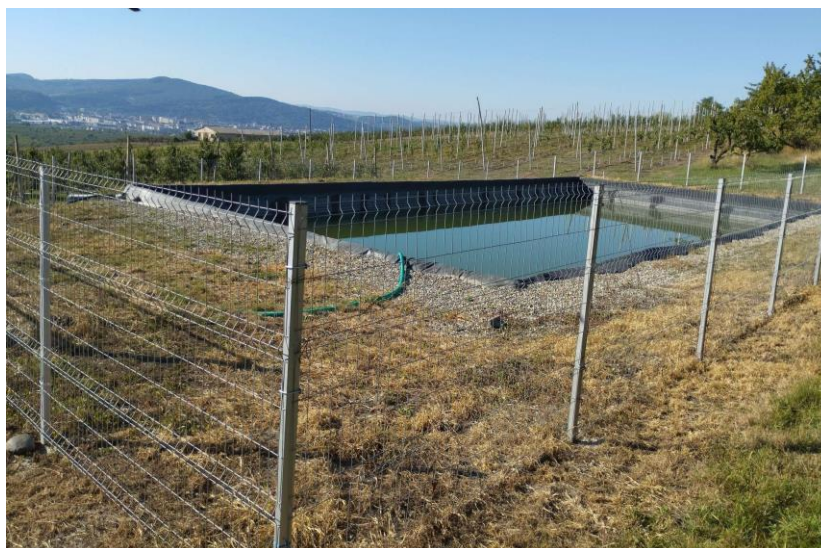
Figura 34. Bazinul de colectare al apei împrejmuit cu panouri de gard bordurat
