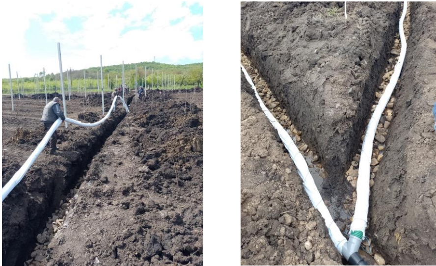
Figura 28. Eliminarea excesului de umiditate din lotul demonstrativ de cireș prin realizarea de drenaje
